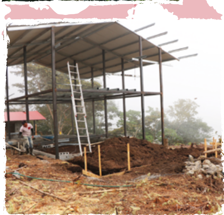
> L'école en construction
